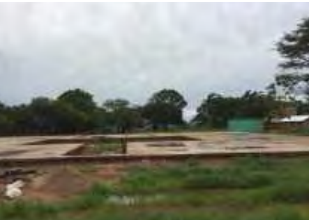
Bodenplatte ist fertig.
