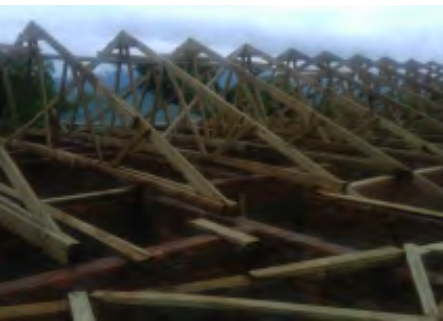
Dachstuhl für das Schwesternhaus
